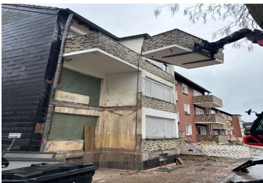
Abbruch der Balkone am Wattenscheider Hellweg 25-29
